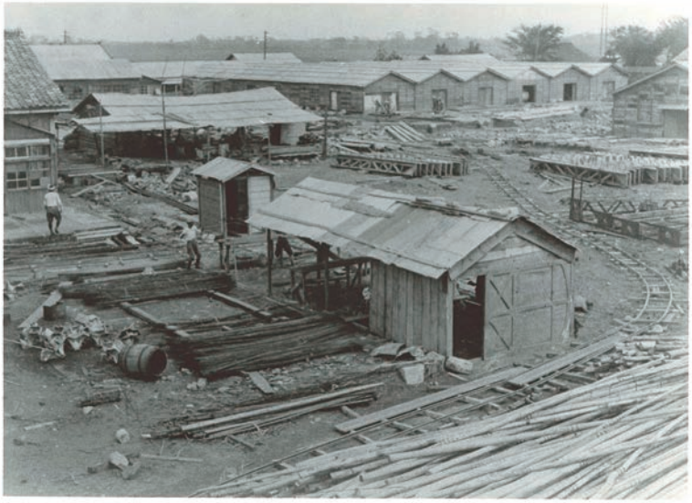
関東大震災後の復興作業（未確認）
