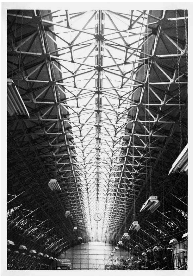
工場のダイヤモンドトラス構造
